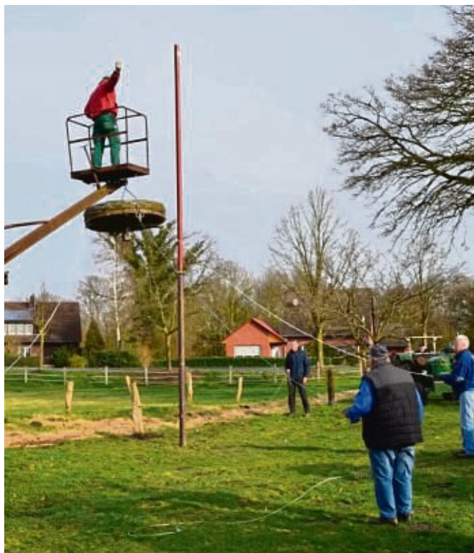
Das Nest wird aufgesetzt und mit Drahtseilen verspannt.
